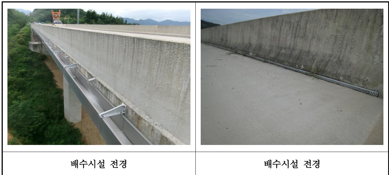
【사진 2.3.46】 배수시설 전경
