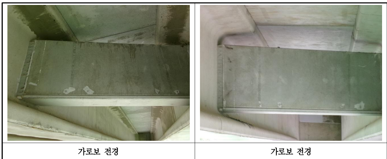
【사진 2.3.6】 가로보 전경
