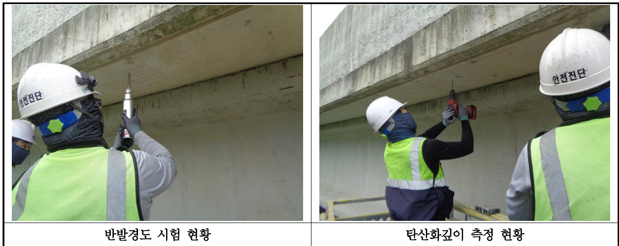
【사진 2.4.1】 콘크리트 내구성조사 현황
