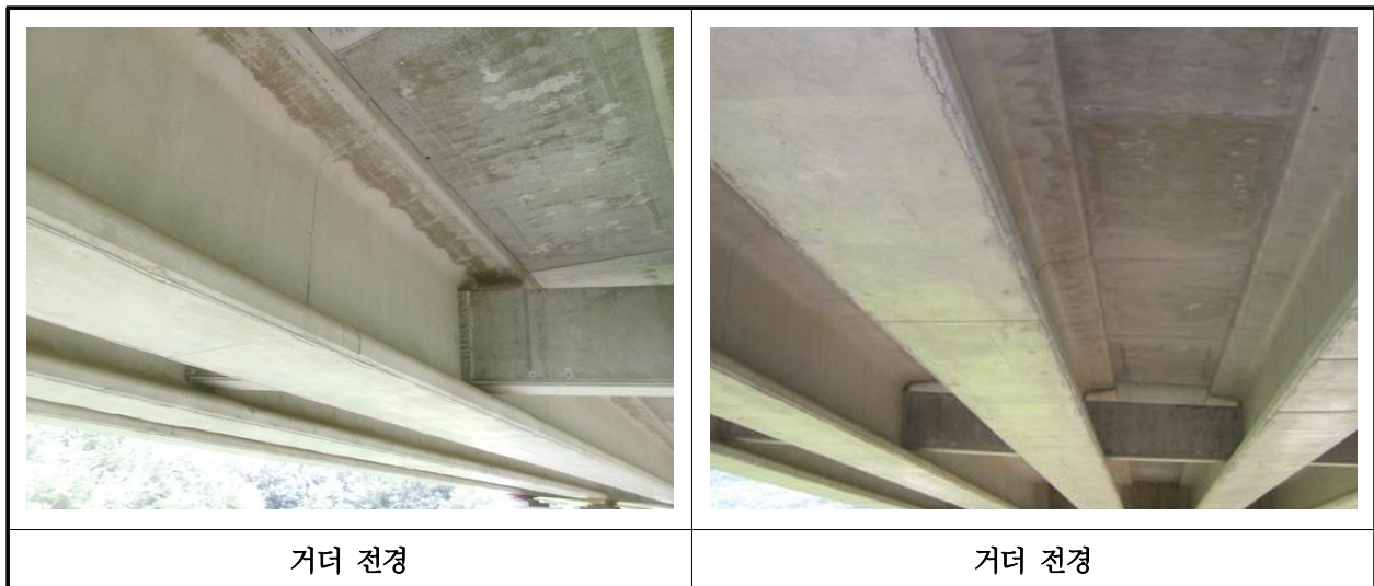
【사진 2.3.4】 거더 전경
