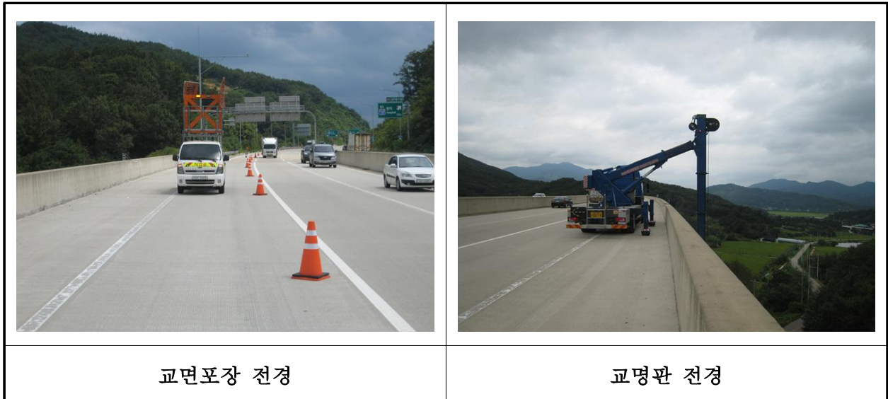
【사진 2.3.19】 교면포장 전경
