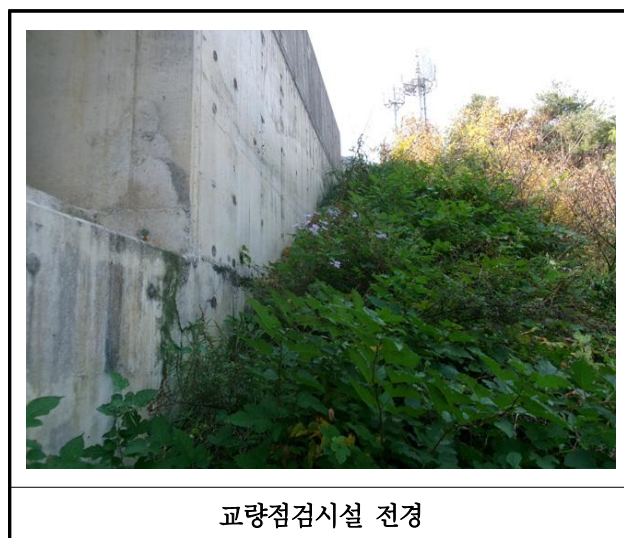
【사진 2.3.25】 교량 점검시설 전경
