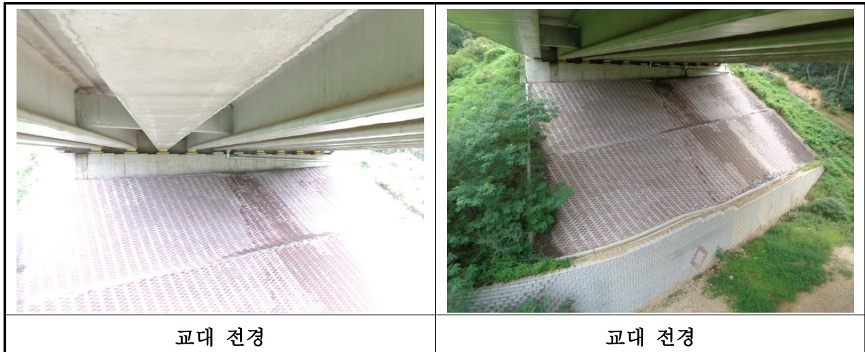
【사진 2.3.8】 교대 전경
