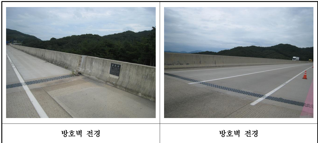
【사진 2.3.48】 방호벽 및 중앙분리대 전경
