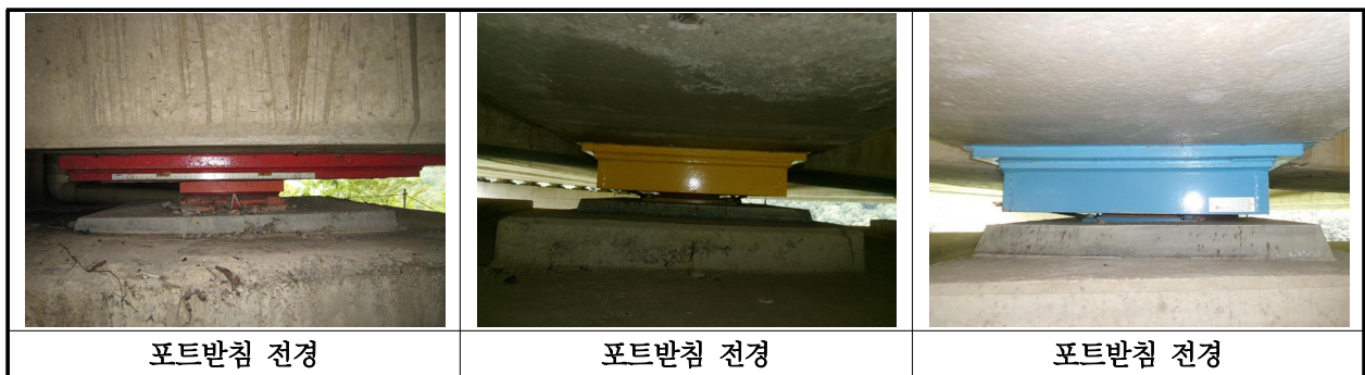
【사진 2.3.37】 교량반침 전경
