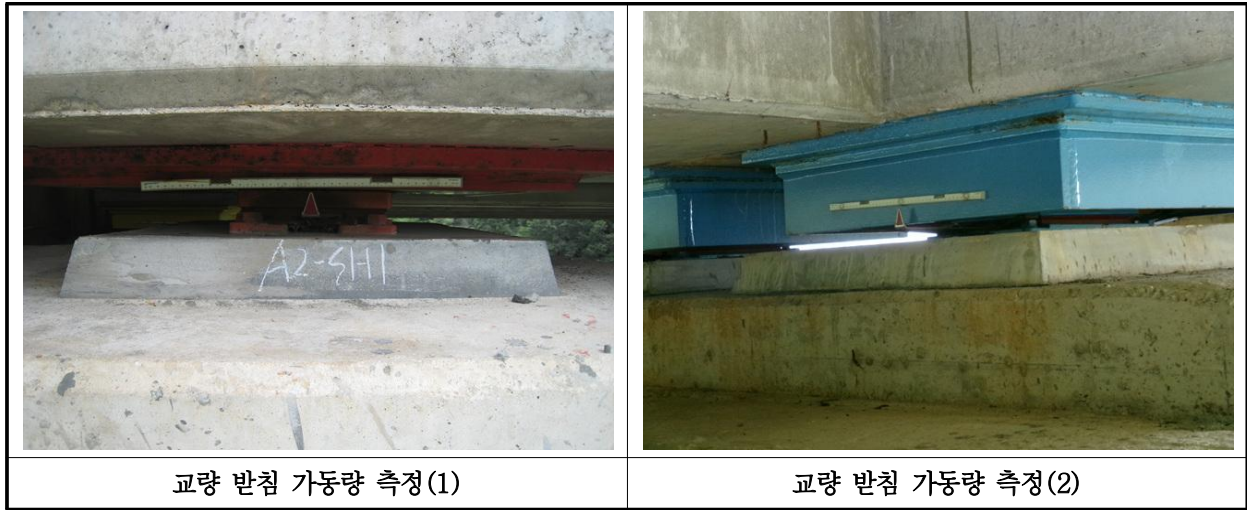
【사진 2.3.15】 교량받침 이동량 측정
