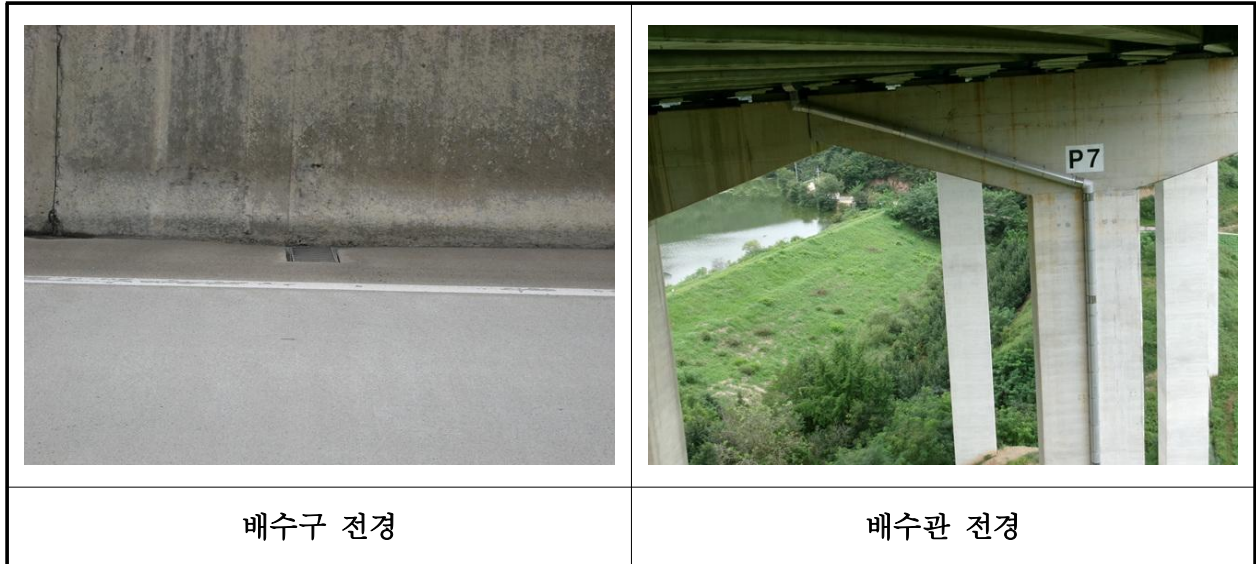
【사진 2.3.21】 배수시설 전경
