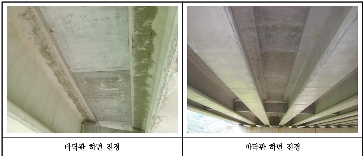
【사진 2.3.2】 바닥판하면 전경
