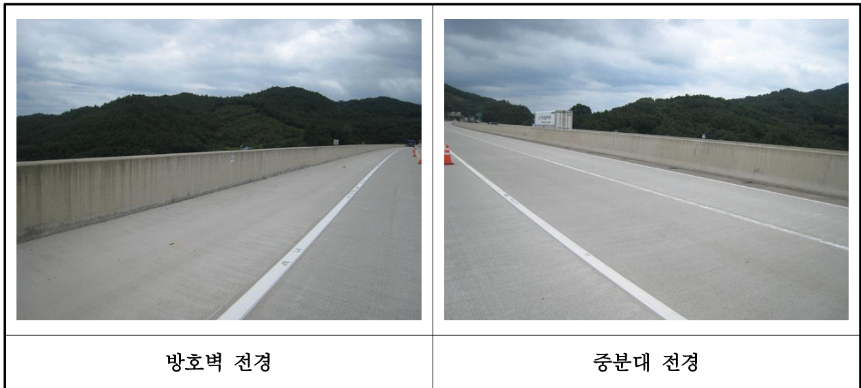
【사진 2.3.23】 방호벽 및 중앙분리대 전경
