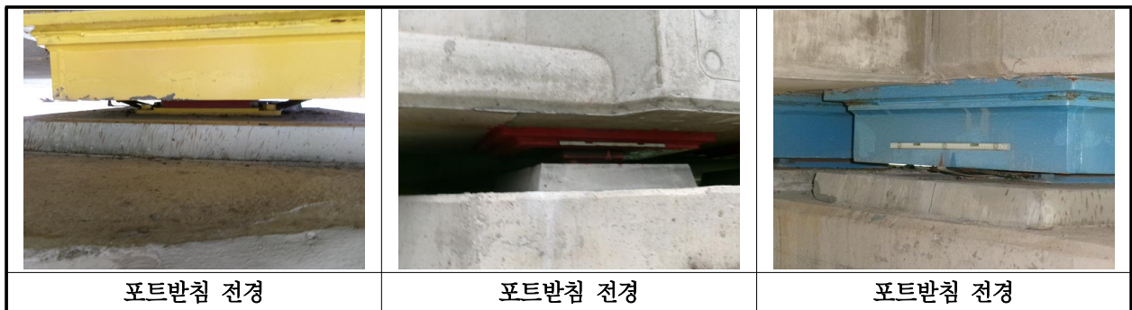
【사진 2.3.12】 교량받침 전경
