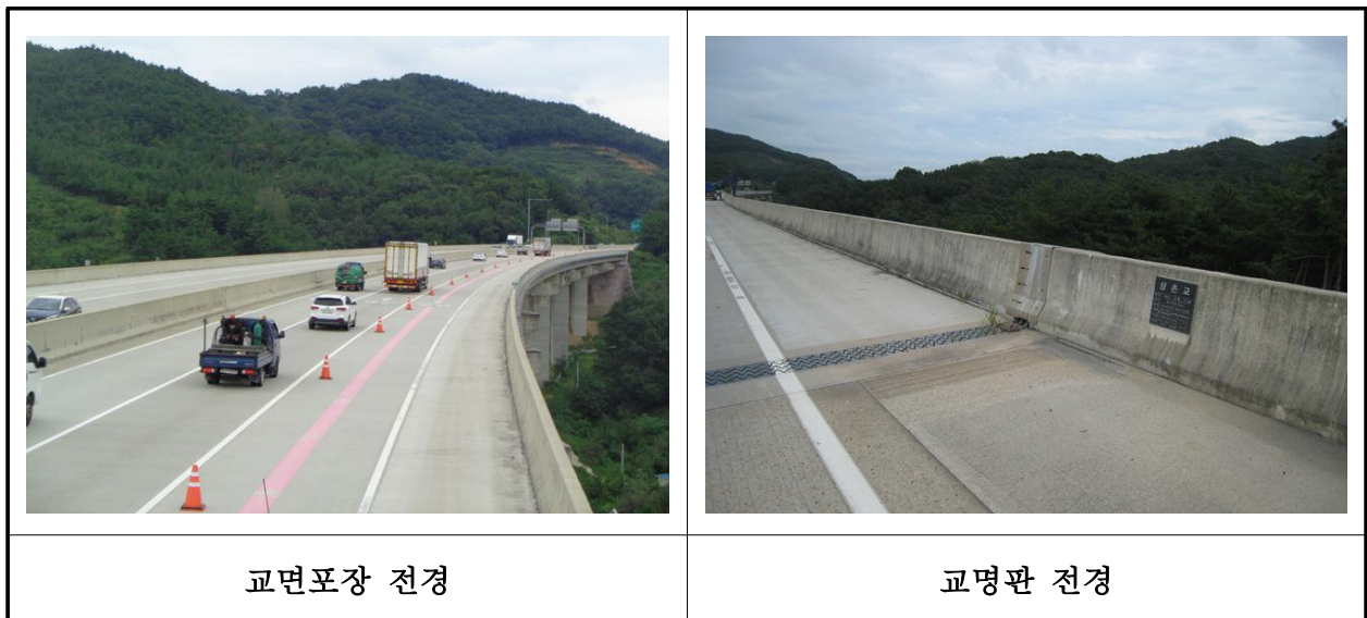
【사진 2.3.44】 교면포장 전경
