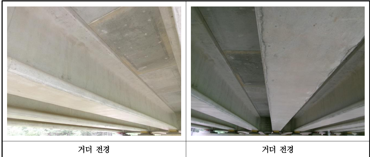
【사진 2.3.29】 거더 전경
