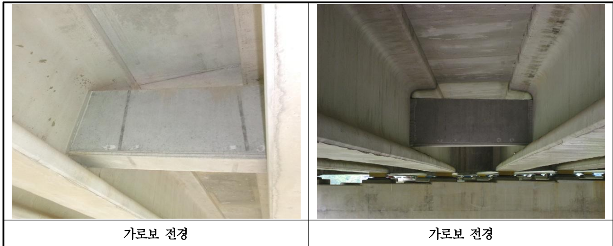
【사진 2.3.31】 가로보 전경
