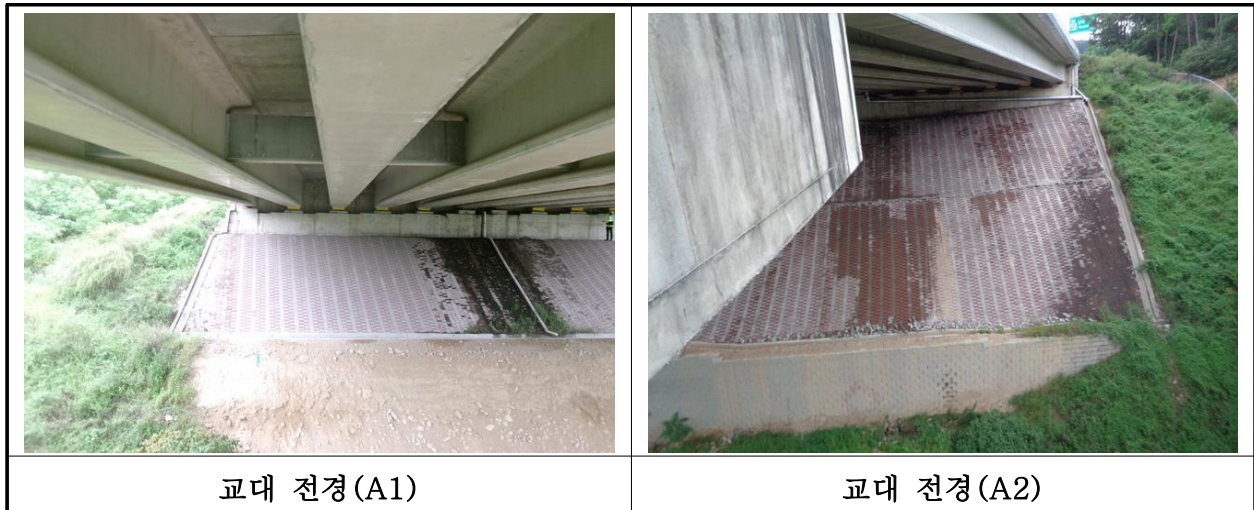
【사진 2.3.33】 교대 전경
