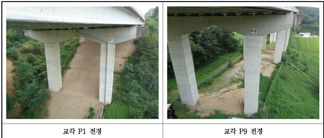
【사진 2.3.10】 교각 전경
